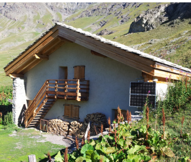
Chalet du Santel - Source : PLU de Tignes
