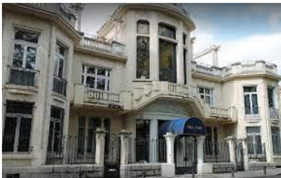
Villa Hatier à Saint-Etienne, monument historique transformé en laboratoire technique de la rénovation
