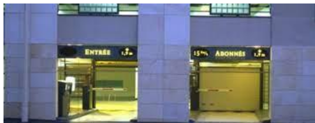
Parking Marché Gare à Confluence à Lyon Optimisation des capacités de stationnement public et privé offertes aux résidents, actifs et visiteurs avec une même place pouvant servir à plusieurs automobilistes
