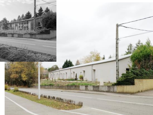
Transformation d'un ancien bâtiment industriel en 9 logements à Saint-Genis-les-Ollières
