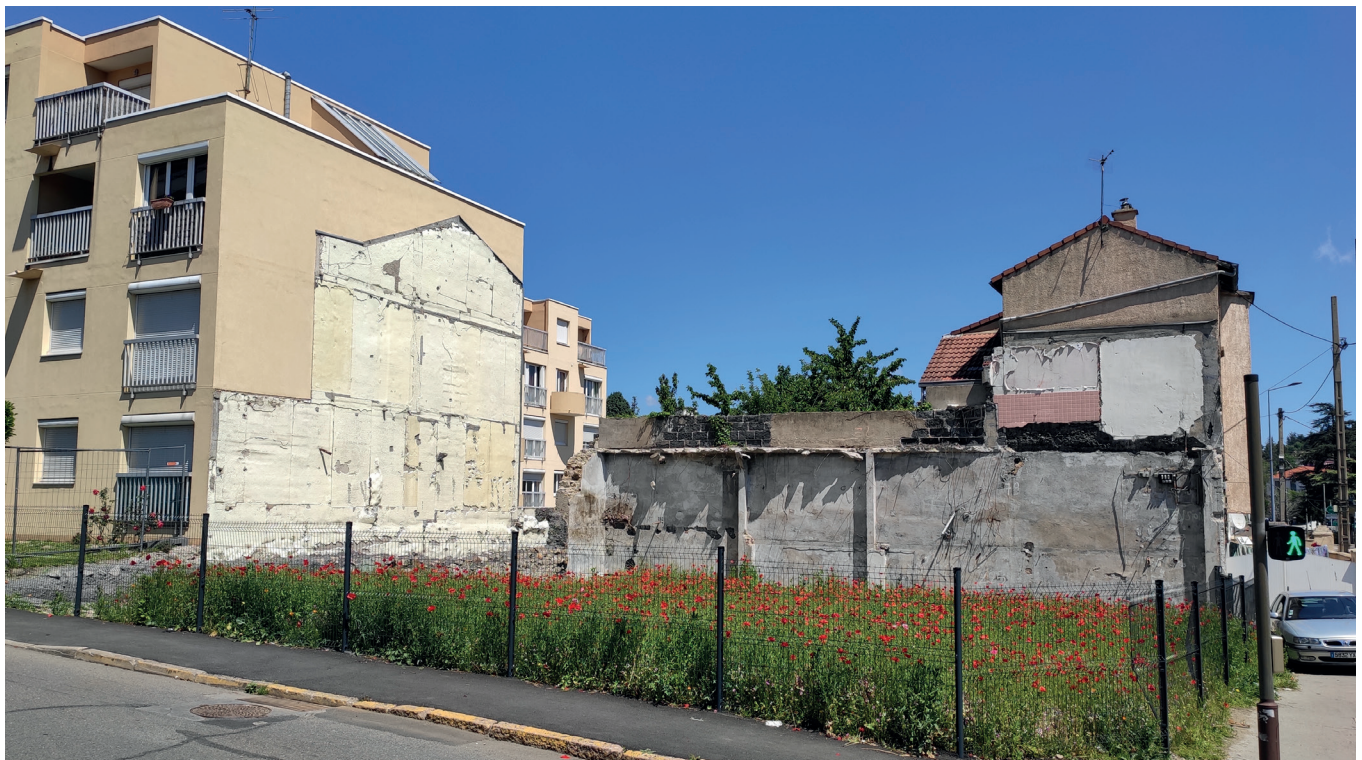
Revégétalisation temporaire suite à la démolition d'un ancien garage automobile, Saint-Etienne © epures
