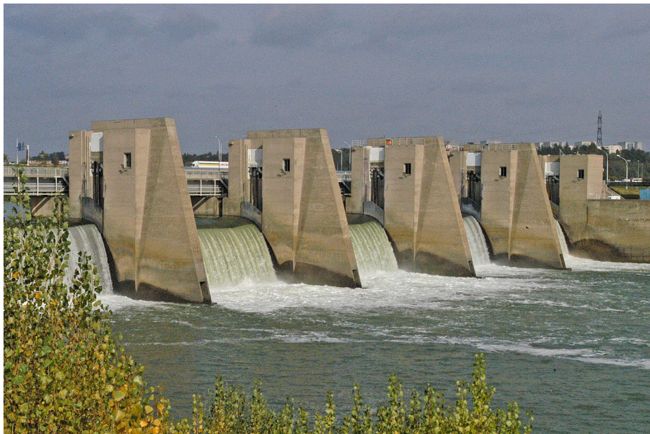
Barrage et centrale hydroélectrique, Pierre Bénite.
