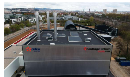
Chaufferie biomasse de Surville dans le quartier de Gerland, Lyon 7 © Dalkia
