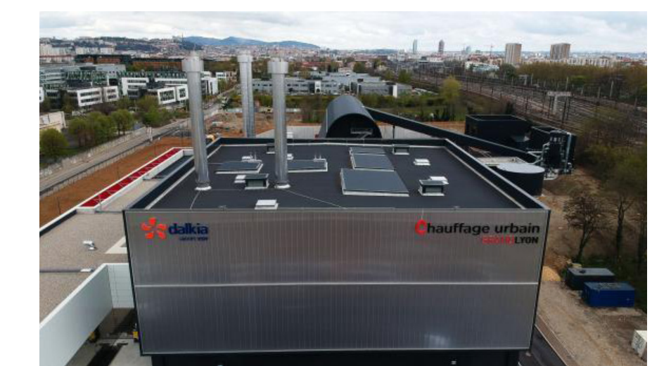
Chaufferie biomasse de Surville dans le quartier de Gerland, Lyon 7 © Dalkia
